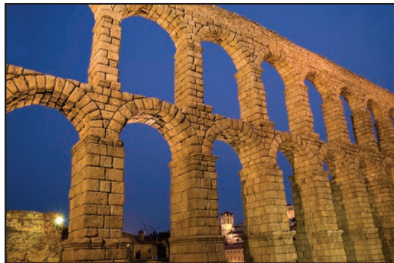
Acueducto romano en Segovia, España
